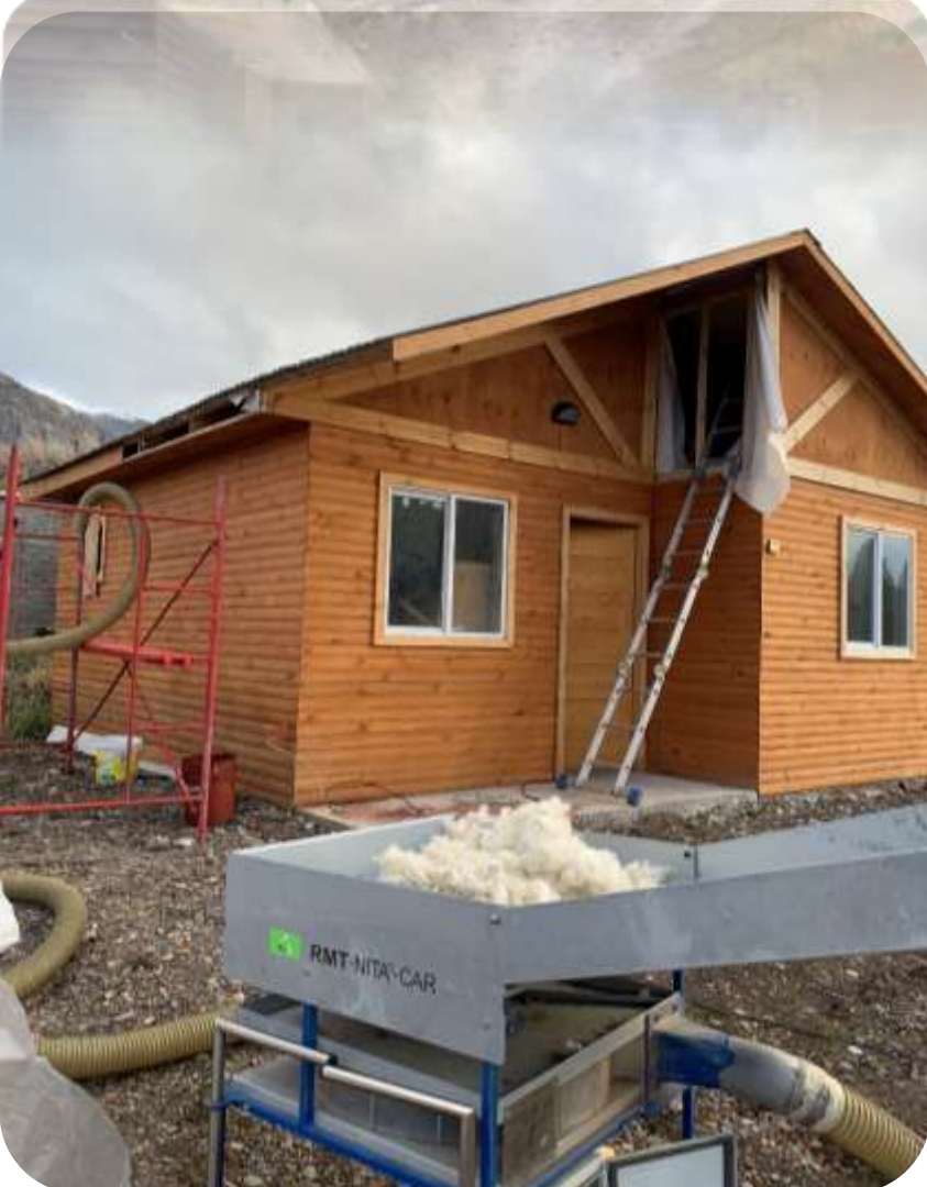
18 Cabañas de turismo, prefabricadas y aisladas con lana de oveja a granel. "Patagonia Wool"
