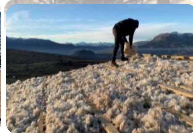
Diseño y Construcción CGA. Casa PANGUILEMU, envolvente térmica de 20 cm, continúa aisladas con lana de oveja a granel.
