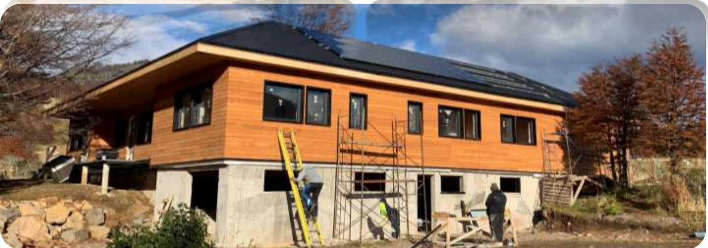
Andrés Villouta Arq. Casa Monreal, Patagonia, Chile, paneles de fabricación y montaje de CLT y envoltente de lana de oveja.
