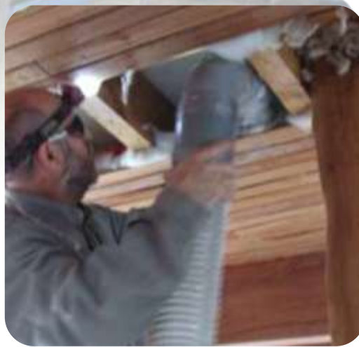
LODGE EL PUESTO, RIO TRANQUILO. ARQUITECTO FRANCISCO CROXATO, Mejoramiento acústico en el entretecho, de la infraestructura turística existente. Se aplico mediante inyectora textil.
