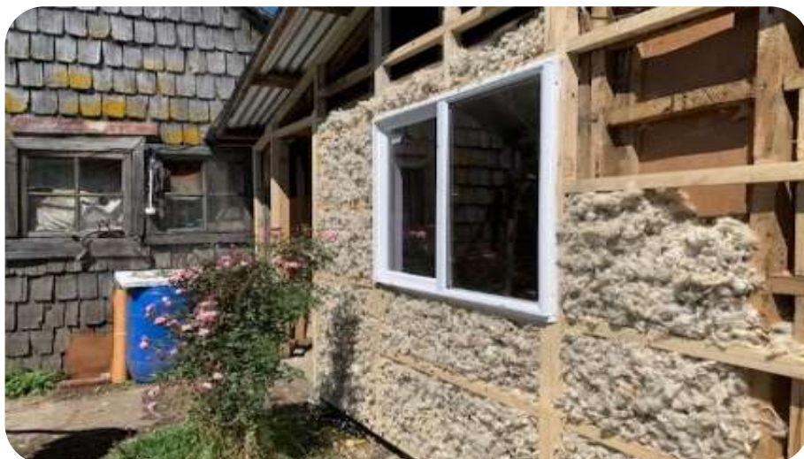
Mejoramiento Termico La Lomita, Coyhaique
