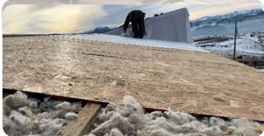
Diseño y Construcción CGA. Casa PANGUILEMU, envolvente térmica de 20 cm, continúa aisladas con lana de oveja a granel.
