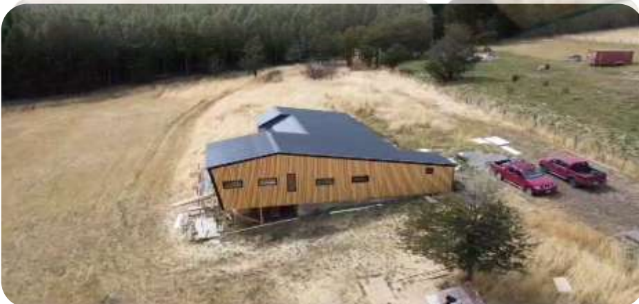
Casa Roldan, 140 m2, prefabricación LANARQ, en base a madera con aislante de Lana de Oveja.
