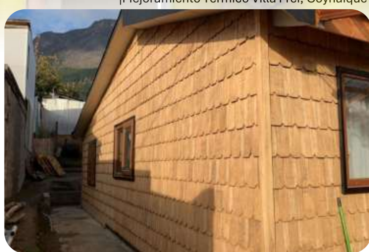
Mejoramiento Termico, Coyhaique
