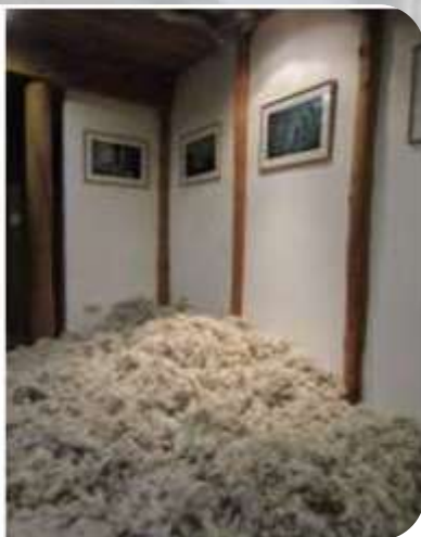
LODGE EL PUESTO, RIO TRANQUILO. ARQUITECTO FRANCISCO CROXATO, Mejoramiento acústico en el entretecho, de la infraestructura turística existente. Se aplico mediante inyectora textil.
