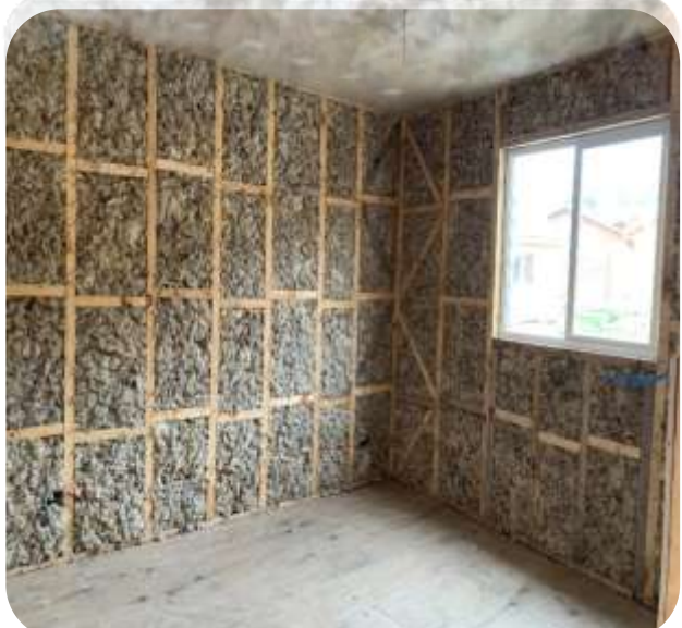
18 Cabañas de turismo, prefabricadas y aisladas con lana de oveja a granel. "Patagonia Wool"
