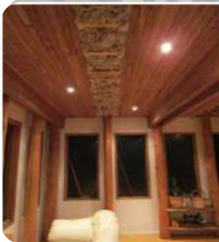
LODGE EL PUESTO, RIO TRANQUILO. ARQUITECTO FRANCISCO CROXATO, Mejoramiento acústico en el entretecho, de la infraestructura turística existente. Se aplico mediante inyectora textil.
